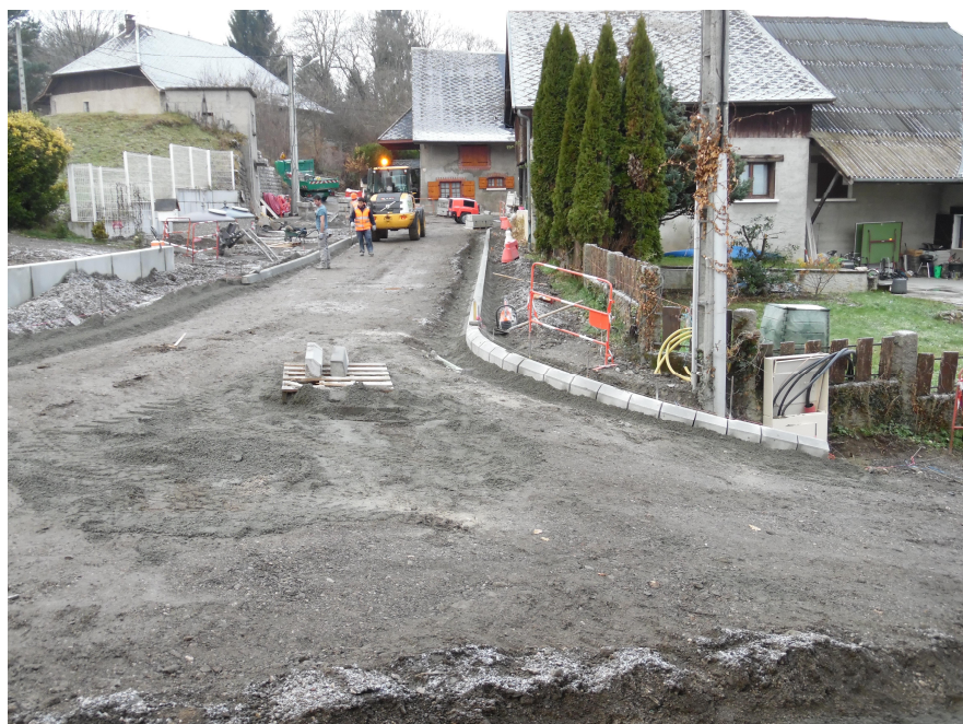
Réfection de la route d'Hauteville, Hameau du Bioley
